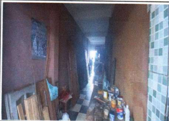
Foto 3: Vista do acesso.
