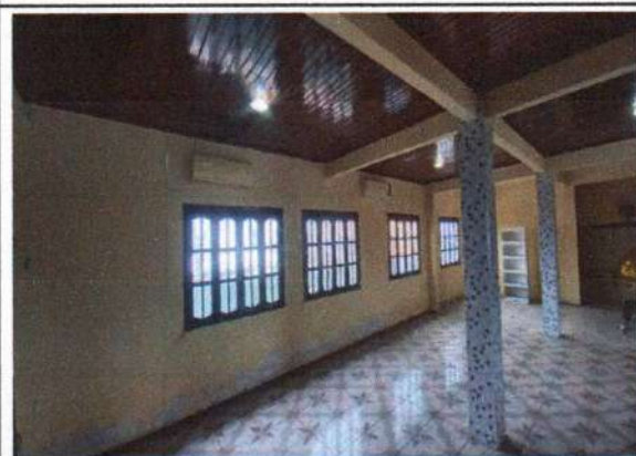
Foto 3: Vista do salão com 04 centrais de ar.
