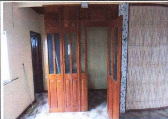
Foto 5: Vista do acesso.
