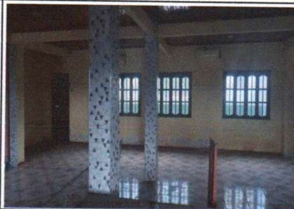
Foto 6: Vista da sala.
