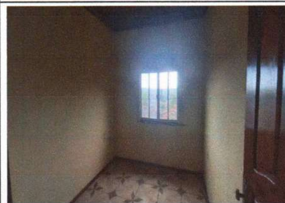
Foto 5: Vista da sala.
