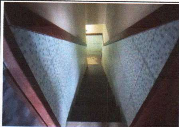
Foto 5: Vista da escada.
