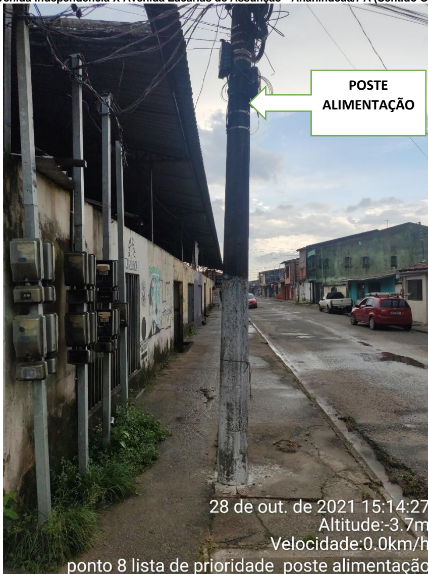
Foto 2: Avenida Independência X Avenida Zacarias de Assunção - Ananindeua/PA (Sentido Oeste/Leste)
